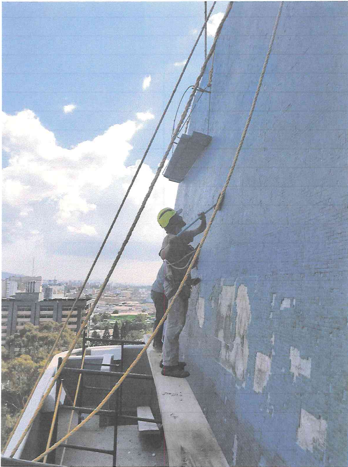
Limpieza y desinfección de teselas en segmento A2 de fachada Oriente.
